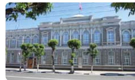
Ул. Ленина, д. 30 здание Правительства Рязанской области (бывшее здание общественного банка Живаго)
